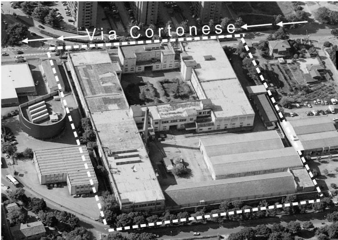
Vista dall'alto dello stabilimento
